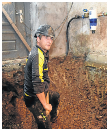
Florian Apel bei der „Feinarbeit“: In die Ecken kommt der Bagger nicht.
