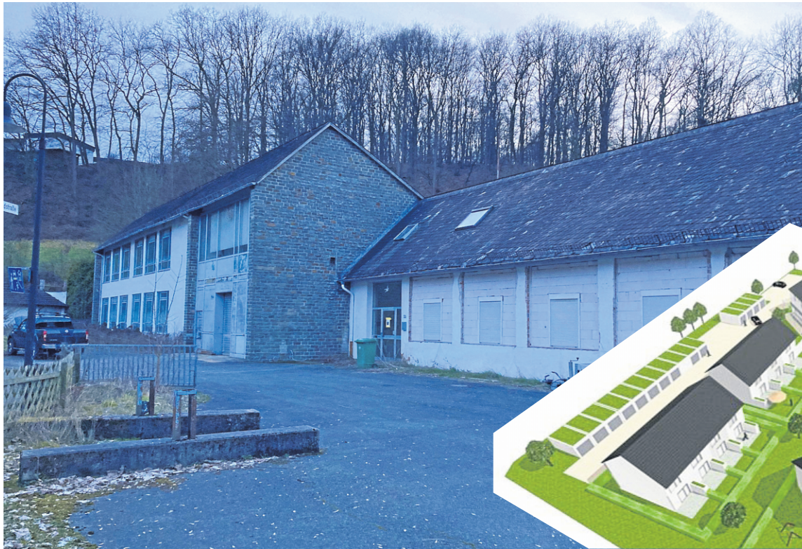
Ein Bild in der Dämmerung: In dieser leerstehenden Industriehalle sowie in ihrem Umfeld an der Lennefeldstraße in Bamenohl entsteht ein neues Wohnquartier. Wie dieses genau aussehen soll, zeigt die Illustration daneben. FLEM-MING KRAUSE/HEIMAT-TAL AG
